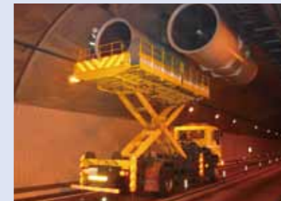
トンネル換気設備設置状況
