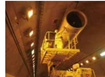
トンネル換気設備点検
